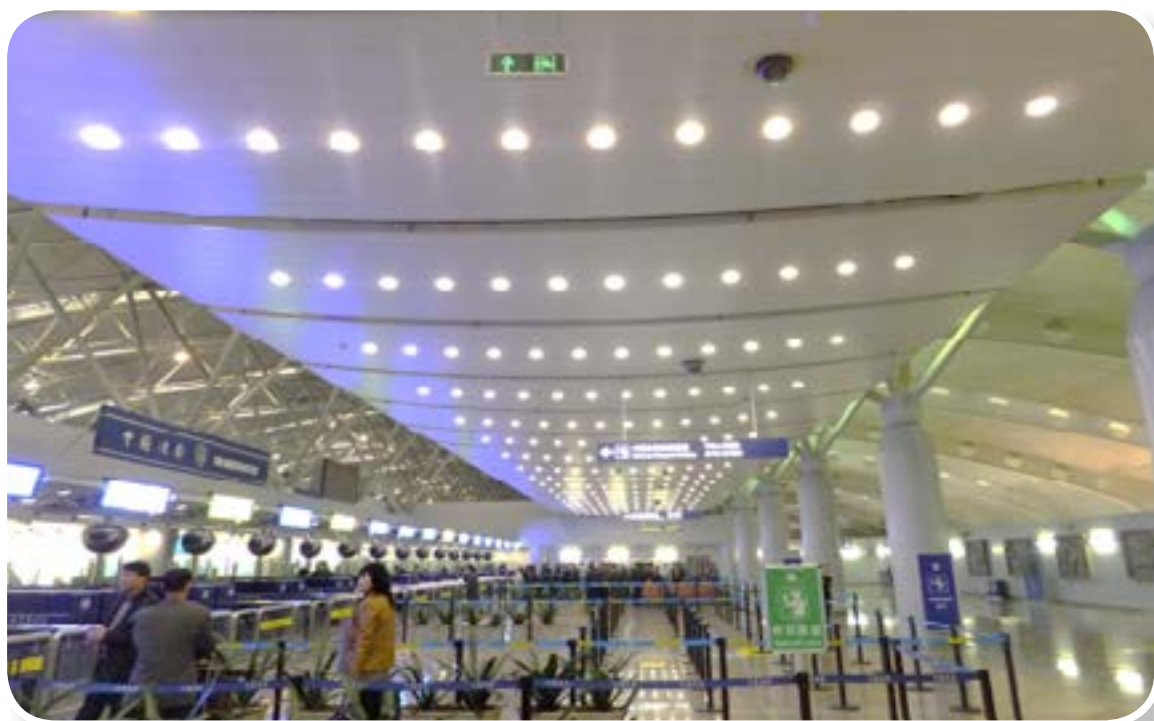
LED 改造后的航站楼
