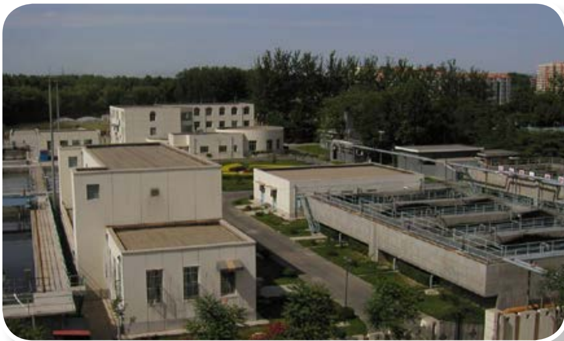
污水净化站全貌
